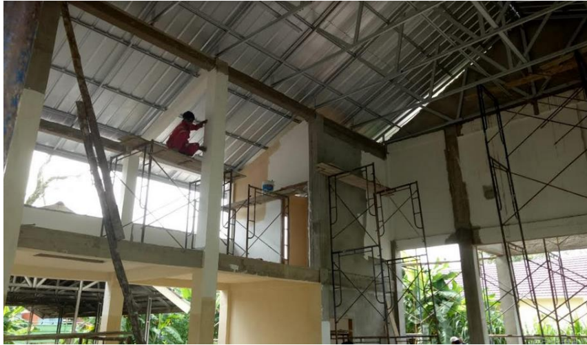
Pembuatan Atap pada Gedung PPDU
